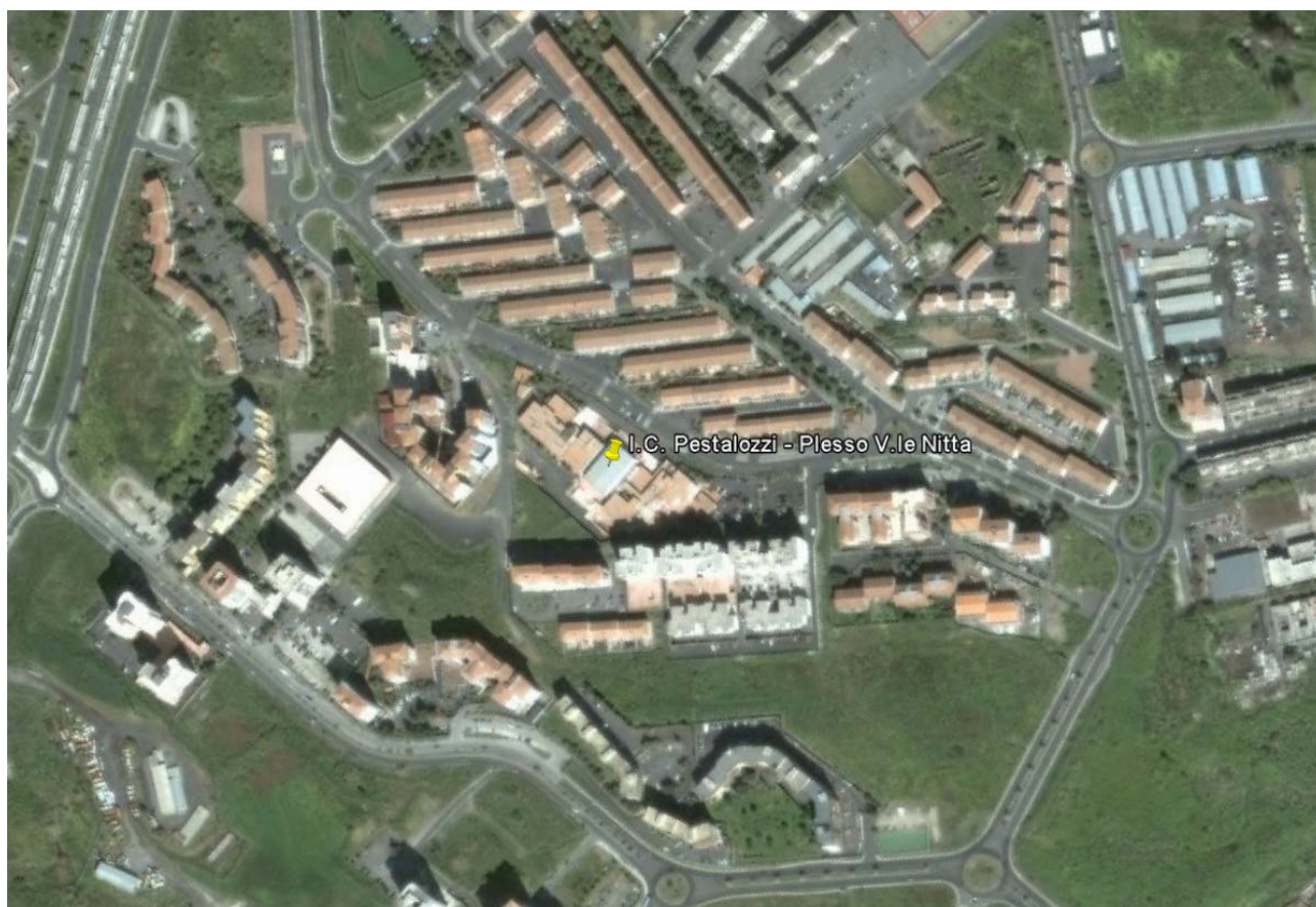
Figura 1: Inquadramento planimetrico dell'Istituto Comprensivo Pestalozzi – Plesso di Viale Nitta
